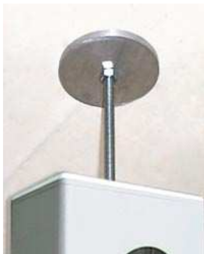
Mocowanie rozporowe słupka.
