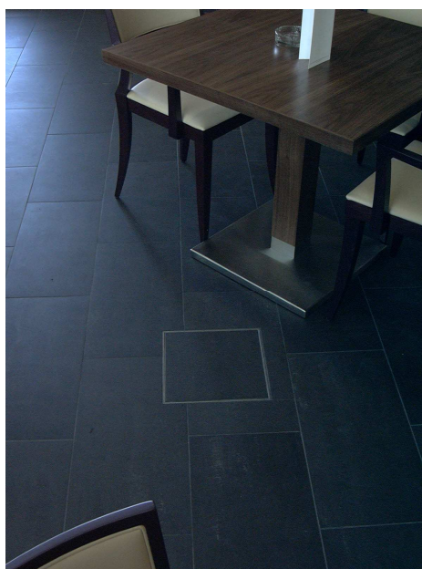
Kaseta HBKK Q12 BL(ślepa), zamontowana w kamieniu.
