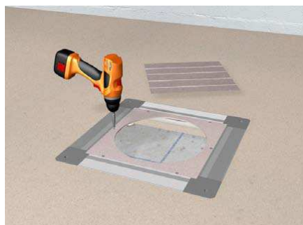
Blachę osłonową puszki UDH3 zamieniamy na właściwą ramę montażową UDM3.
