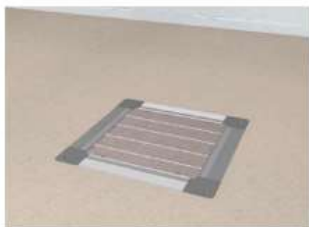
Montaż ramy montażowej w osadzonej na gotowo puszcze UDH3.
