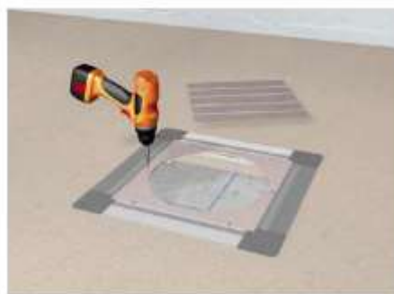
Montaż ramy montażowej w osadzonej na gotowo puszcze UDH3.
